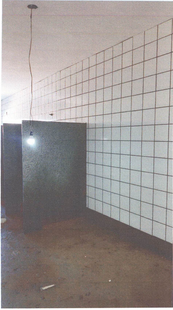
Contrapiso / Revestimento azulejo
