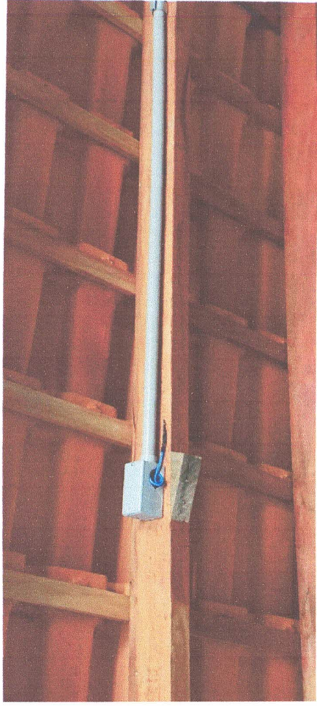
Fiação e tubulação área externa
