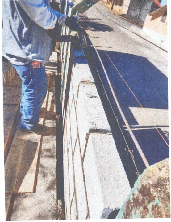
Alvenaria em bloco muro
