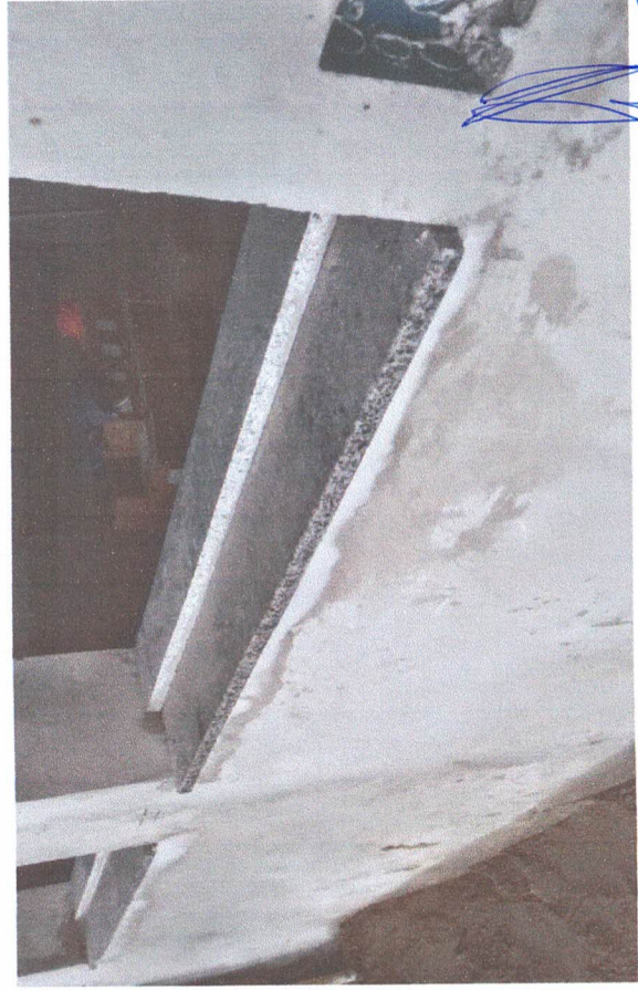
Reboco Externo / Peitoril em granito
