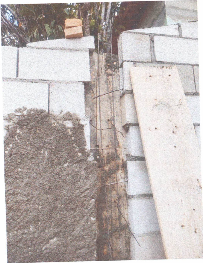
Alvenaria muro e pilar
