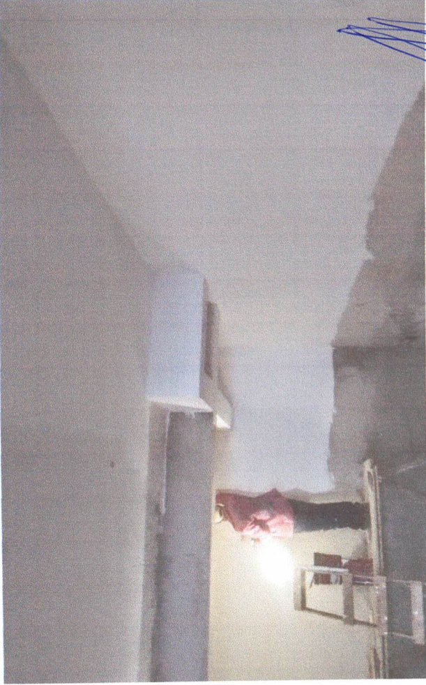
Lixamento e aplicação de massa corrida
