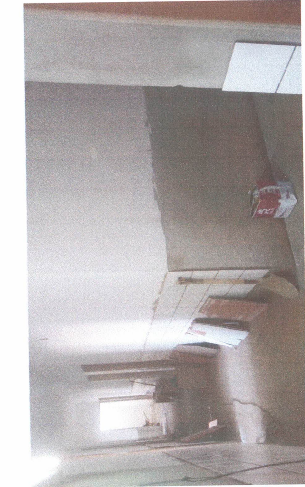
Lixamento e aplicação de massa corrida
