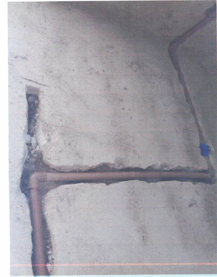
Instalações hidráulicas / Emboço e contrapiso
