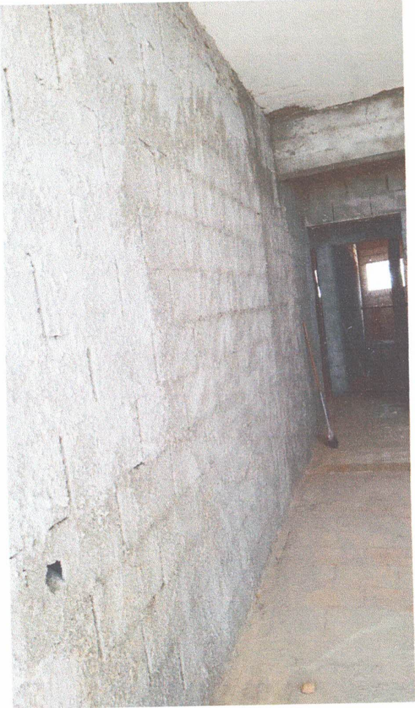
Chapisco / Rebobo e Emboço internos
