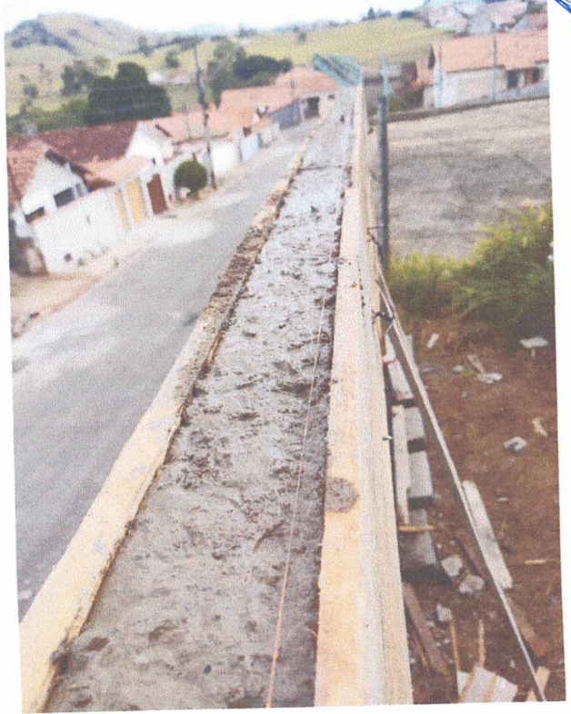
Concretagem viga respaldo
