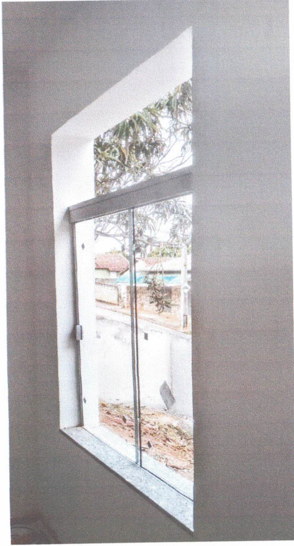
Esquadrias de alumínio com vidro temperado
