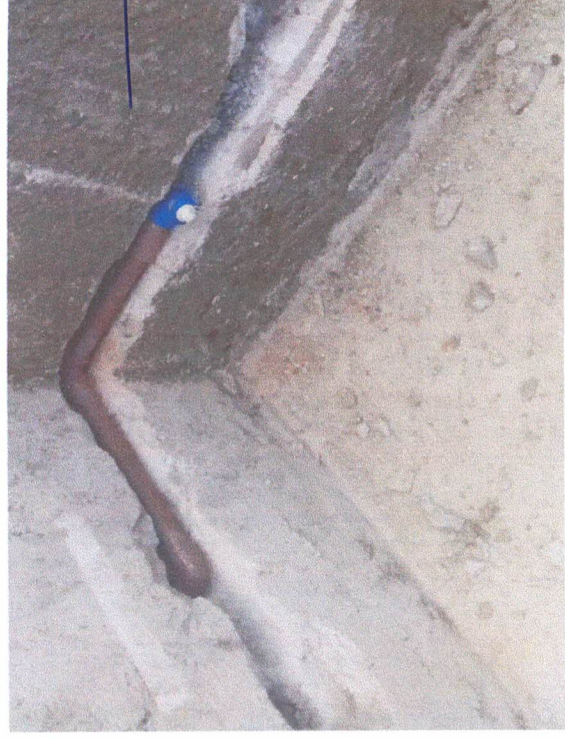
Instalações hidráulicas / Emboço e contrapiso
