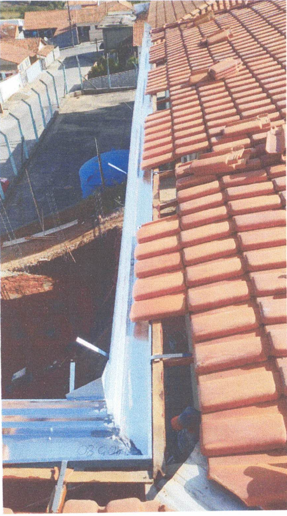
Colocação de calhas e rufos
