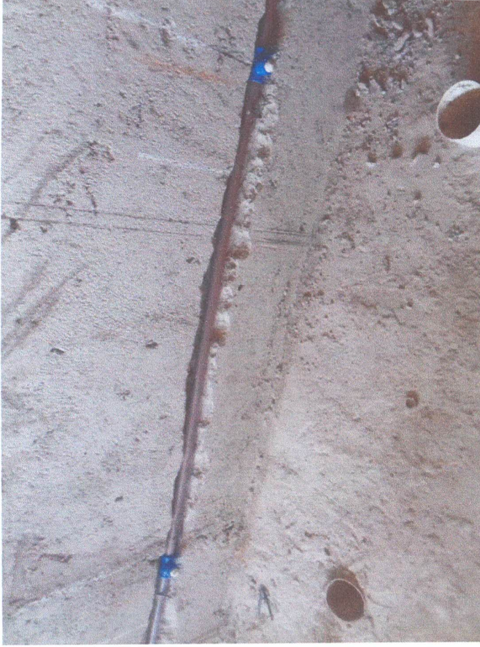
Instalações hidráulicas / Emboço e contrapiso
