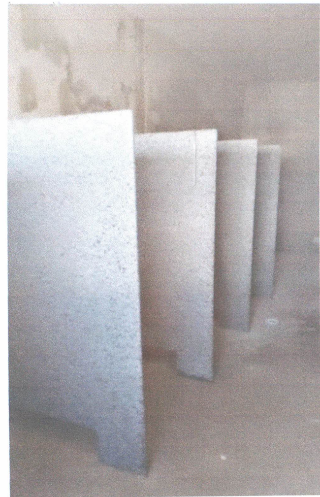
Colocação de divisórias em granito
