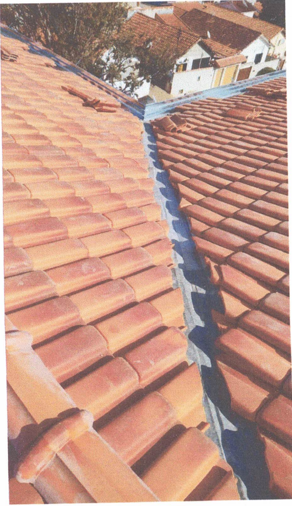
Colocação de calhas e rufos
