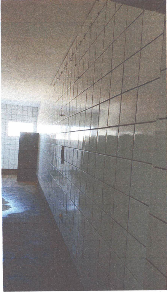
Contrapiso / Revestimento azulejo
