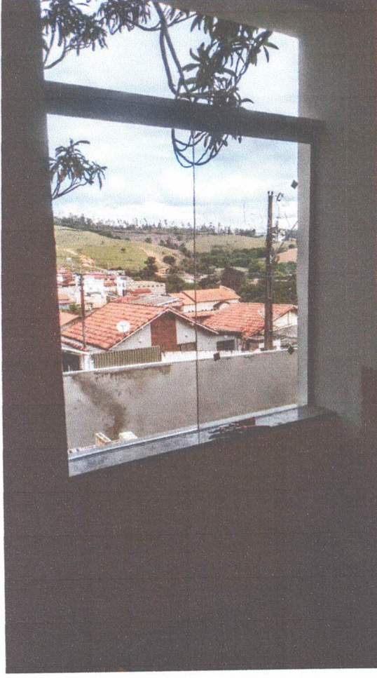
Esquadrias de alumínio com vidro temperado
