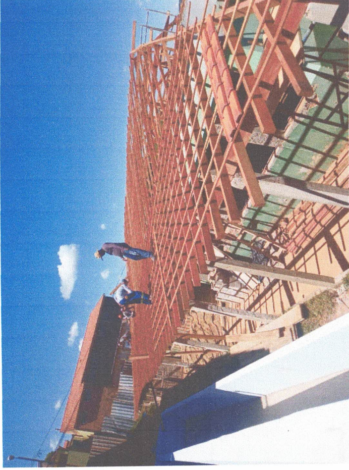
Engradamento e colocação de telhas
