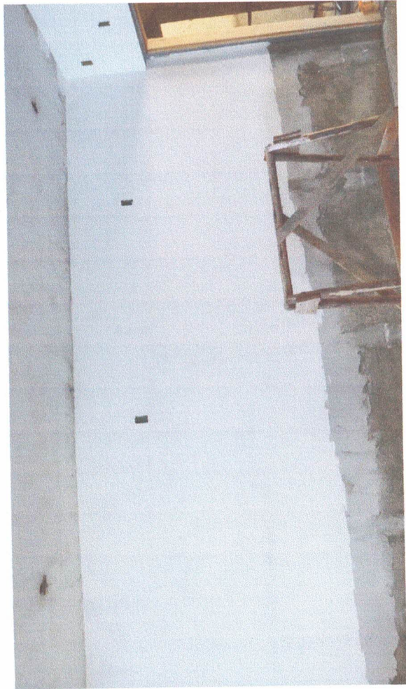
Lixamento e aplicação de massa corrida
