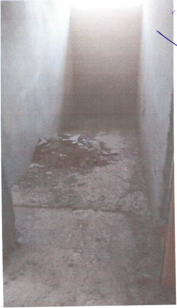
Chapisco / Rebobo e Emboço internos
