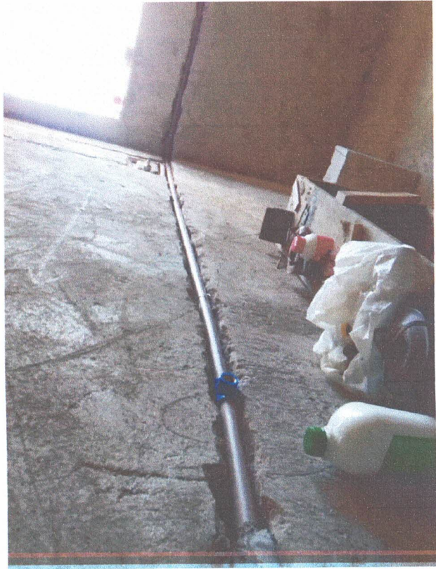
Instalações hidráulicas / Emboço e contrapiso
