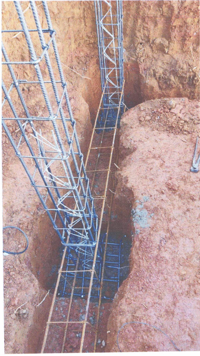
Fundação muro arrimo
