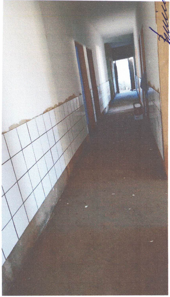
Contrapiso / Revestimento azulejo
