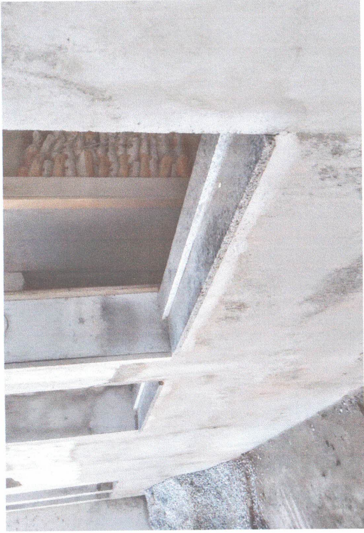
Reboco Externo / Peitoril em granito
