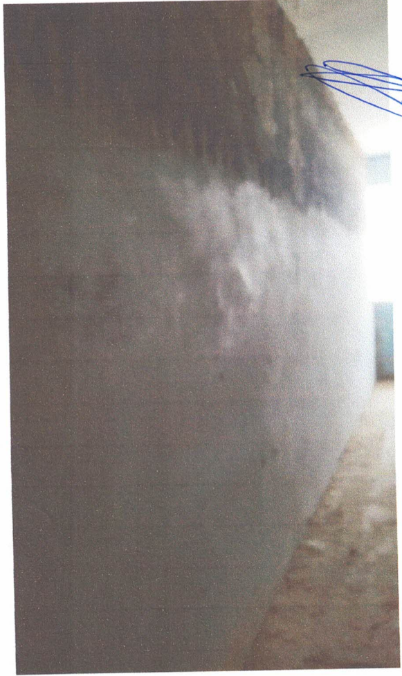
Chapisco / Rebobo e Emboço internos
