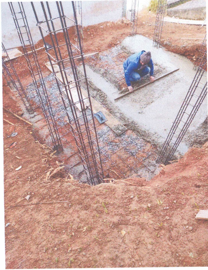
Concretagem piso armado para reservatório d'água
