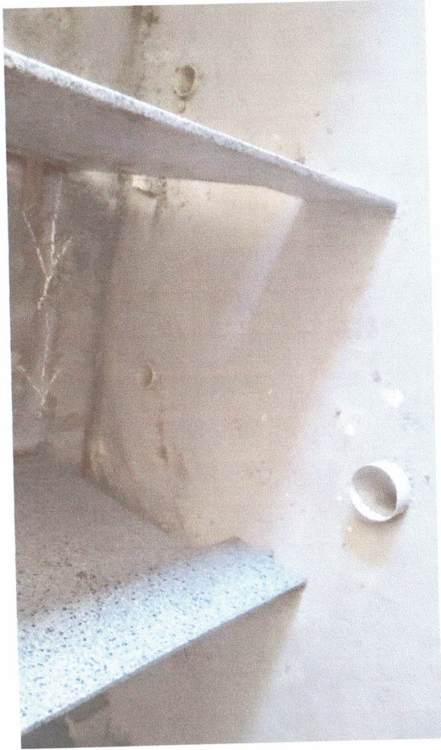
Colocação de divisórias em granito
