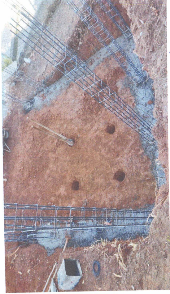
Escavação estacas brocas base reservatório
