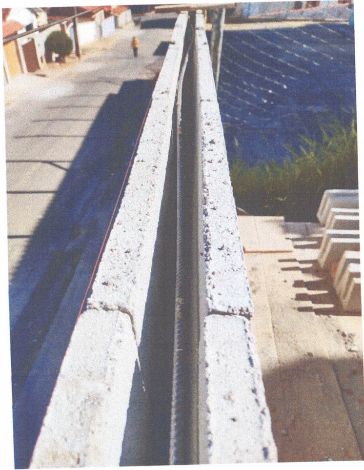
Alvenaria em bloco canaleta - muro / Ferragem
