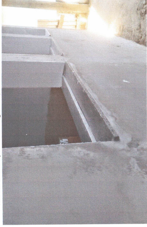
Reboco Externo / Peitoril em granito / Massa Corrida interna
