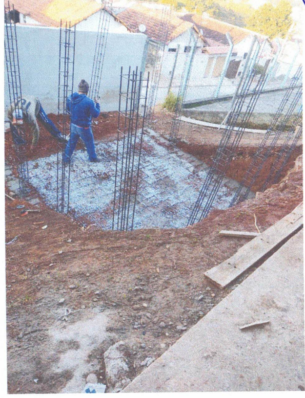
Fundação muro arrimo
