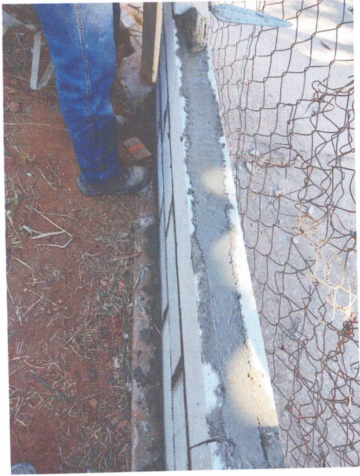
Alvenaria em bloco canaleta concretada
