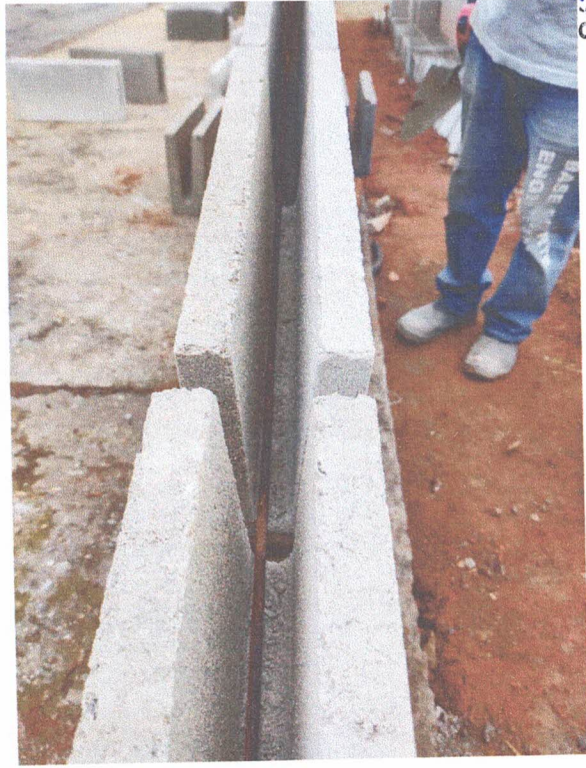
Alvenaria em bloco canaleta do muro / Ferragem
