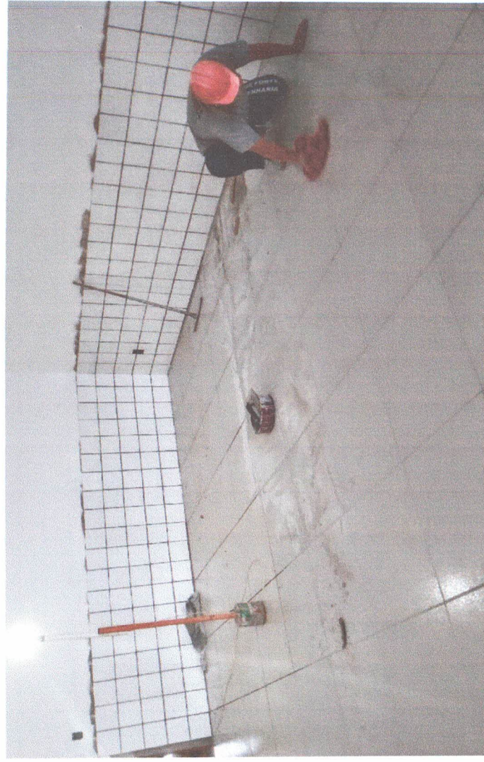
Revestimentos cerâmicos pisos e azulejos / Rejuntamento
