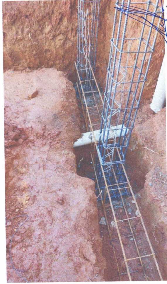
Fundação muro arrimo
