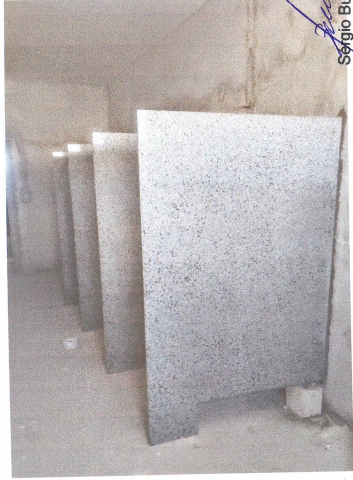
Colocação de divisórias em granito
