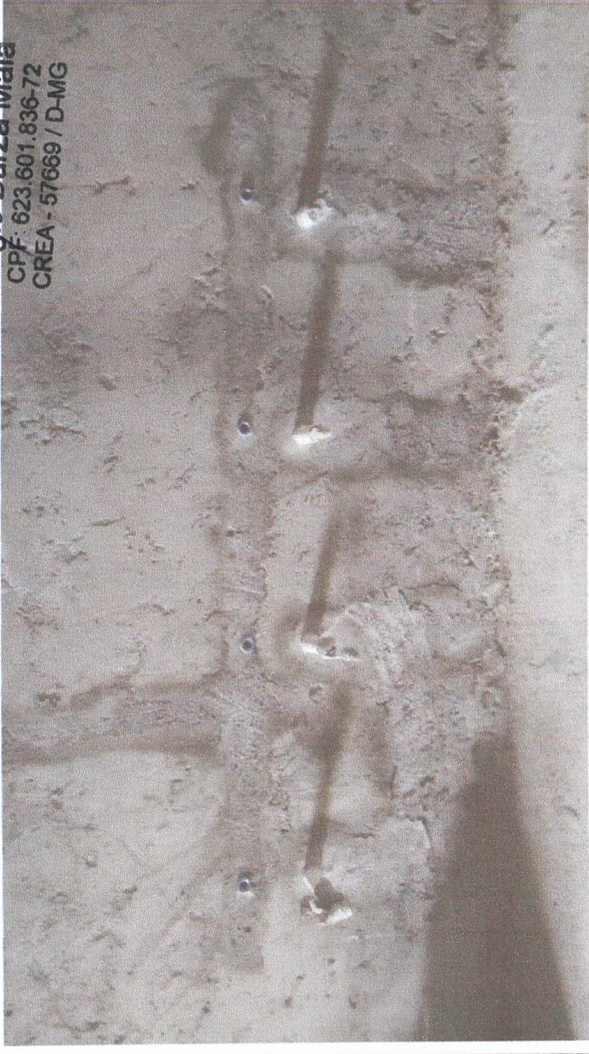
Emboço / Tubulações hidráulicas água e esgoto
